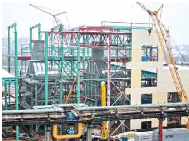
Работы по реконструкции Минской ТЭЦ-2 ведутся РУП «Белэнергострой», 2011 год
