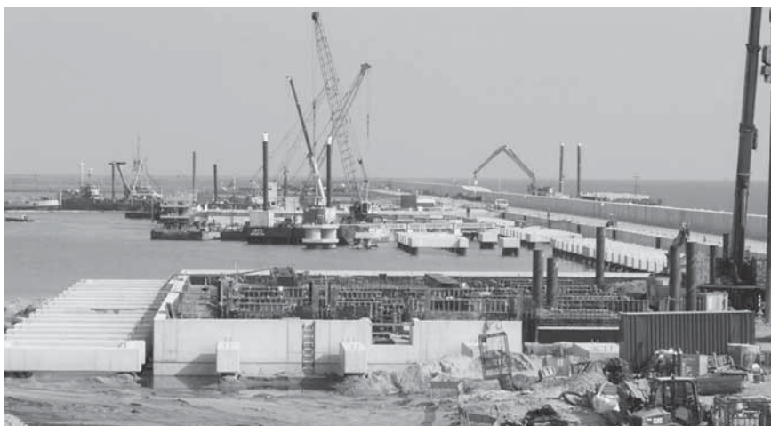
Строительство газового терминала в г. Свиноуйсьце
