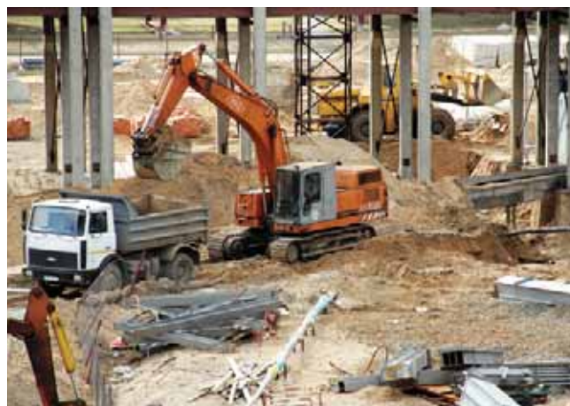
Земляные работы на строительной площадке Минской ТЭЦ-5 ведут специалисты РУП «Белэнергострой»
