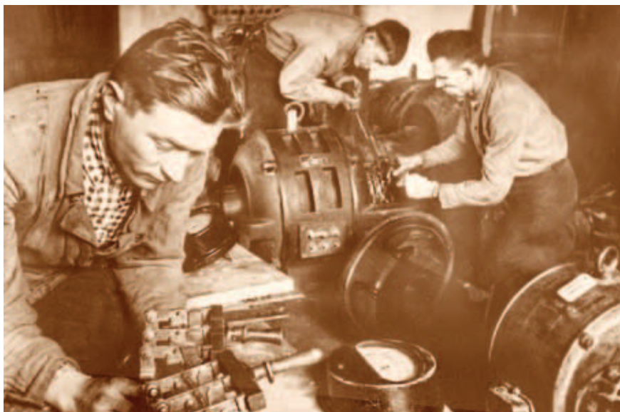
Молодежная бригада на восстановлении Гомельской электростанции, 1944 год
