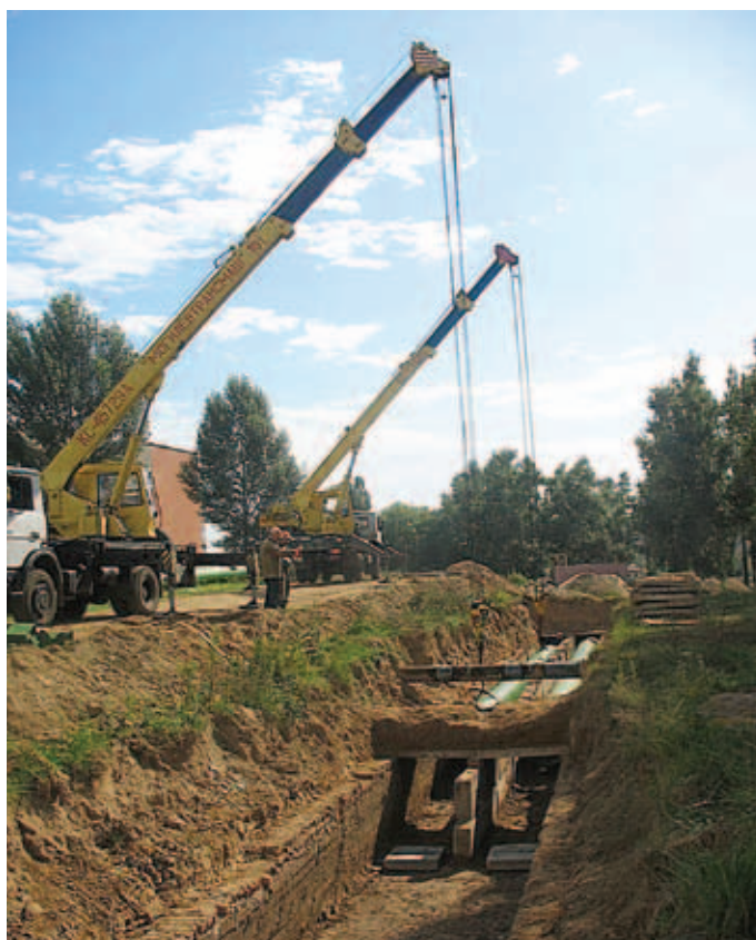
Проводится капитальный ремонт теплотрассы
