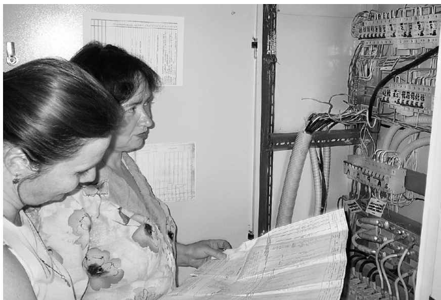
Государственные инспекторы Гомельского межрайонного отделения Е.П. Мельник и Ж.Ф. Максоцкая проверяют соответствие выполненных электромонтажных работ проекту
