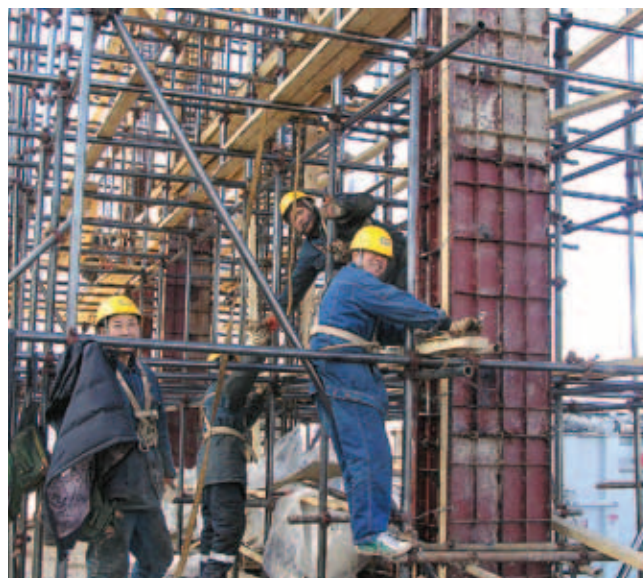
Китайские специалисты монтируют защитную железобетонную перегородку между трансформаторами Лукомльской ГРЭС
