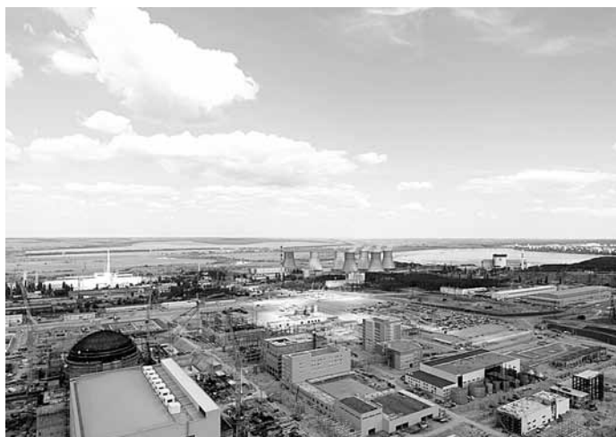
Рис. 1. Вид на стройплощадку Нововоронежской АЭС-2 (на фоне работающего блока № 5)
