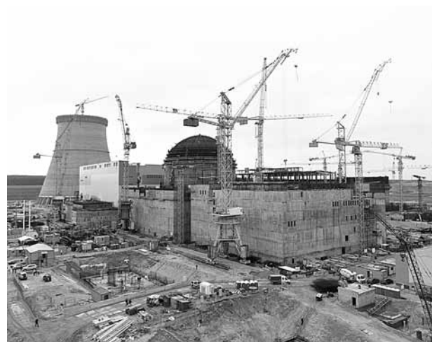
Рис. 2. Вид на стройплощадку Нововоронежской АЭС-2 (в центре – реакторное отделение)
