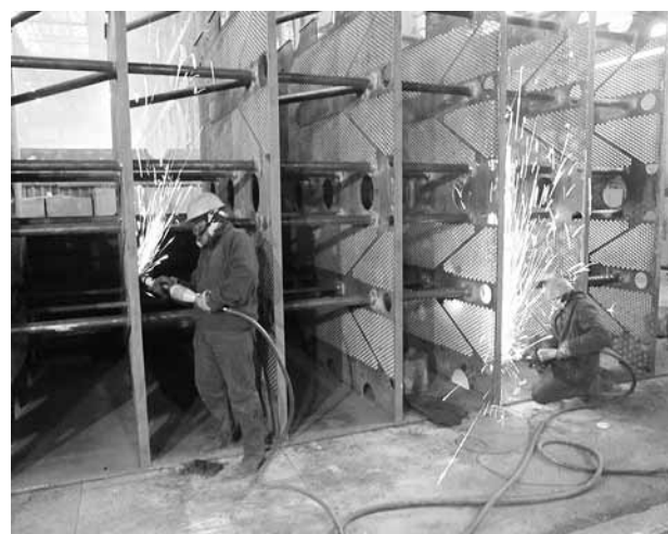
Рис. 5. Изготовление конденсатора для Ростовской АЭС
