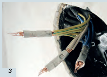
Рис. 1. Контактное соединение с использованием пайки
