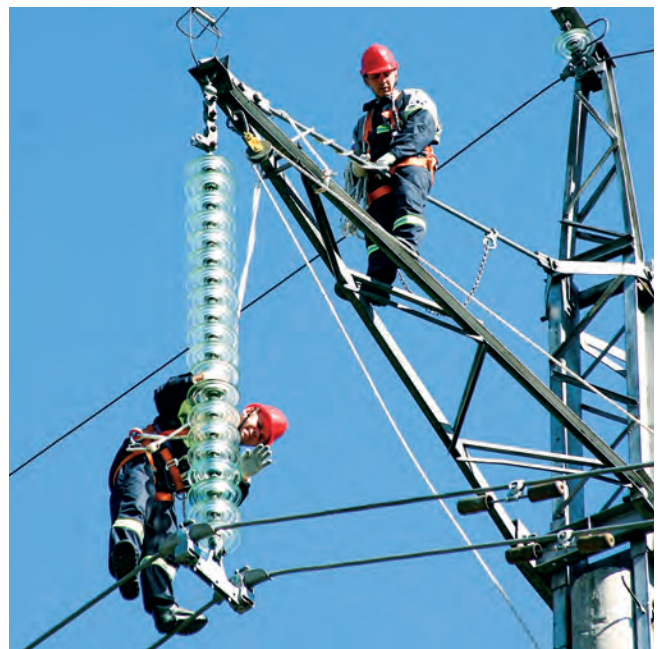
Монтаж опоры ВЛ 330 кВ
