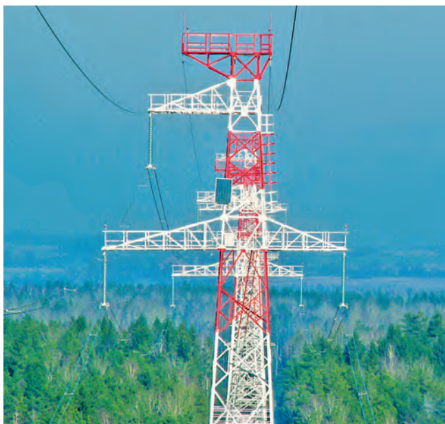
Повышенные опоры облегченного типа
