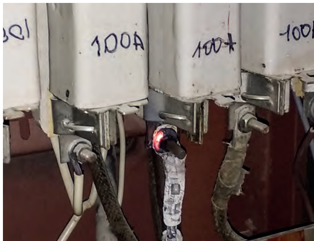
Рис. 2. Раскаленные контактные соединения
