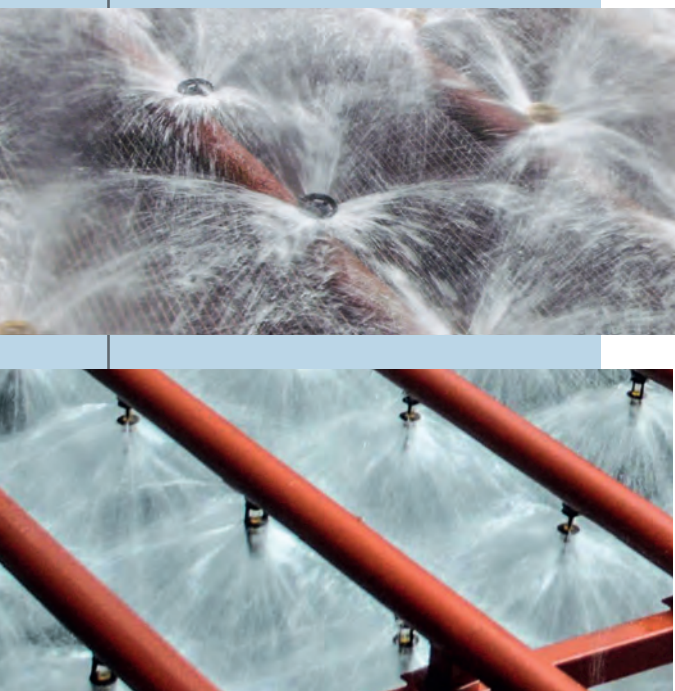
Рис. 7. Работа градирни с соплами старой (вверху) и новой конструкции
