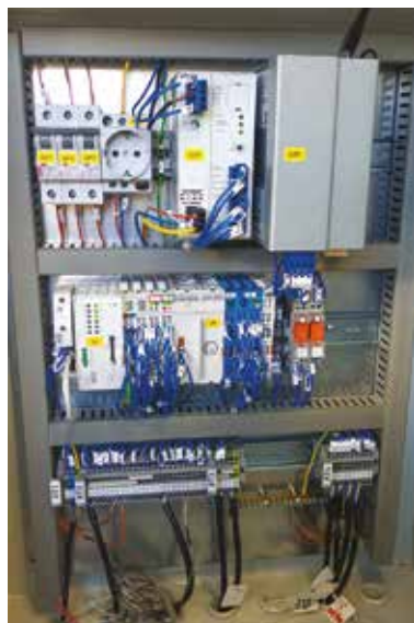
Рис. 3. Шкаф телеметрии для управления температурным режимом и дистанционного съема данных о параметрах ГРП и потреблении электроэнергии
