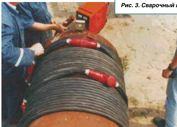
Рис. 4. Размагничивание трубопровода с использованием сварочного выпрямителя
