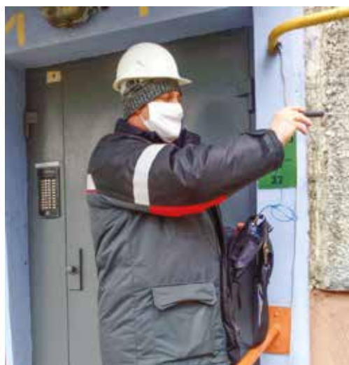
Инспектор газотехнической инспекции Гомельского МРО А.А. Фоменков при определении утечки газа на вводном газопроводе жилого дома
