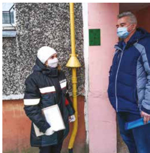
Инспектор газотехнической инспекции Мозырского МРО С.В. Некрасова и председатель правления ЖПК № 15 г. Мозырь при осмотре вводного газопровода
