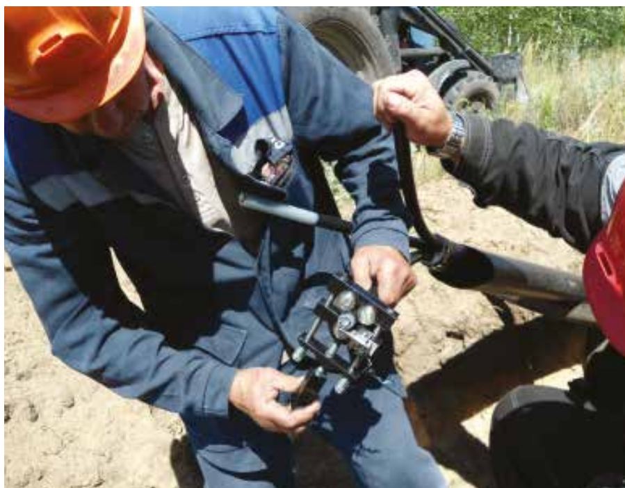
Монтаж соединительной муфты на кабеле с изоляцией из сшитого полиэтилена на ВЛ 10 кВ
