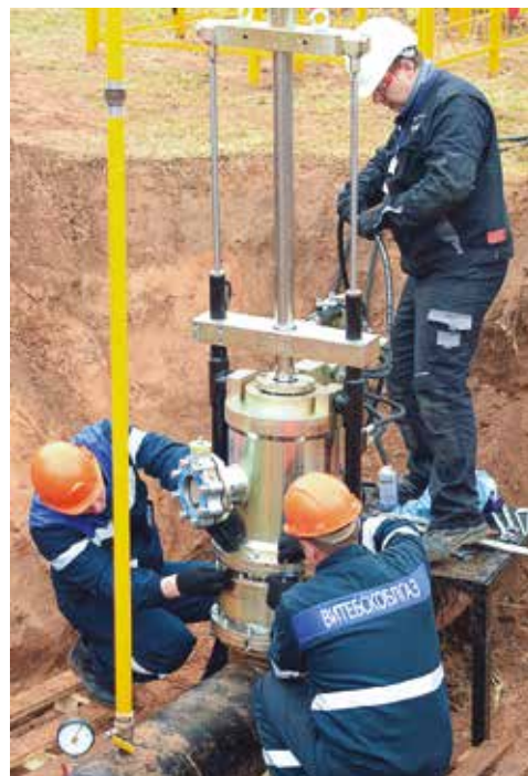
Применение стоп-системы при проведении ремонтных работ на газопроводе
