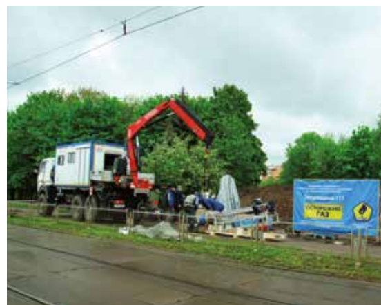
Устройство котлована на месте производства работ по выполнению «холодной врезки»
