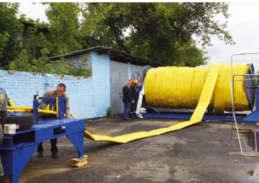
Подготовка полимерного рукава к работе
