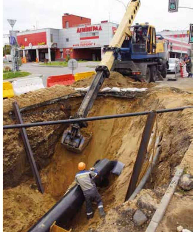
Выполнение санации газопровода высокого давления в г. Минске
