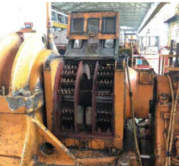
Щеточный аппарат возбудителя на одном из турбоагрегатов Лукомльской ГРЭС
