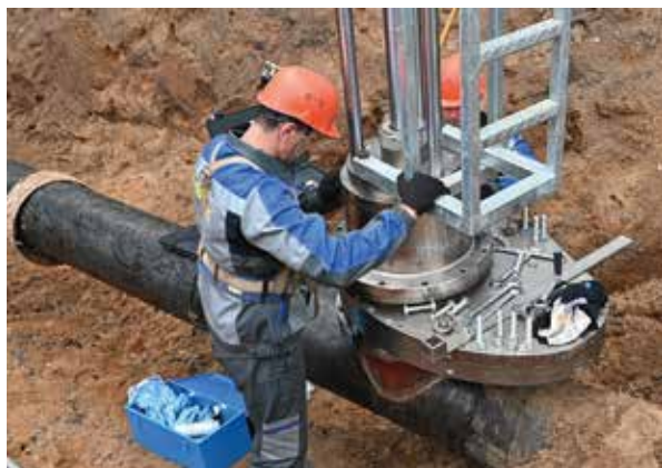
Процесс установки стоп-системы на газопроводе высокого давления
