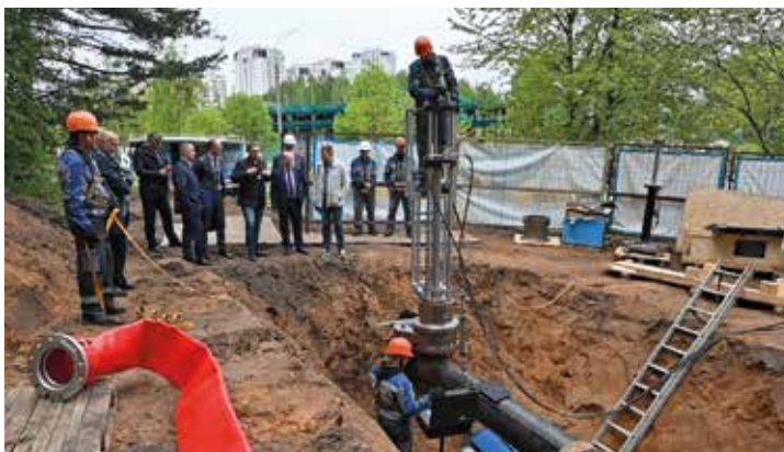
Процесс установки стоп-системы на газопроводе высокого давления
