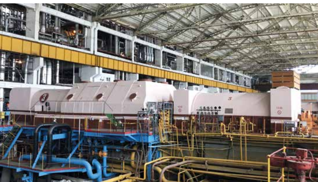
Турбоагрегат № 3 Лукомльской ГРЭС (слева сторона турбины, справа – генератора)
