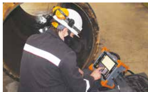
Процесс настройки дефектоскопа и контроль с его использованием
