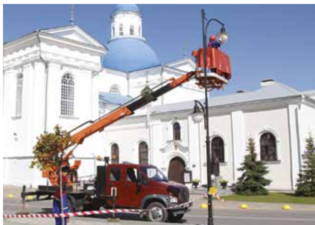
Работа под напряжением, аг. Жировичи
