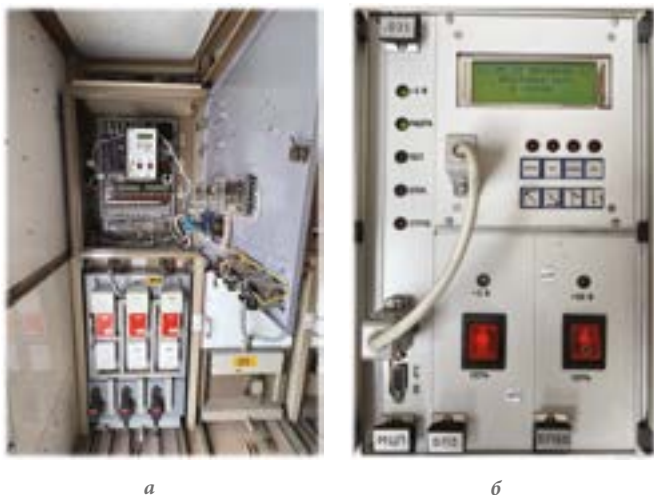
Рис. 1. Силовой (а) и микропроцессорный (б) блоки управления системы ОМЗАЛ-3
