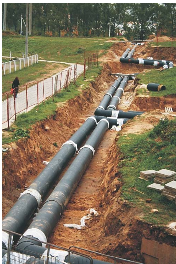
Прокладка ПИ-трубопроводов с термоусаживаемыми муфтами
