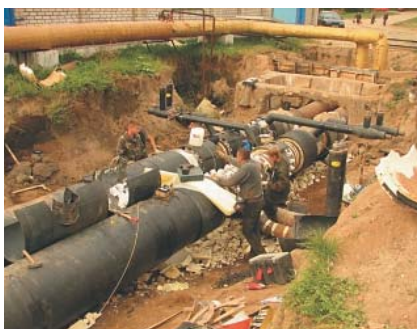
Устранение дефектов (мест увлажнения) на ПИ-трубопроводе
