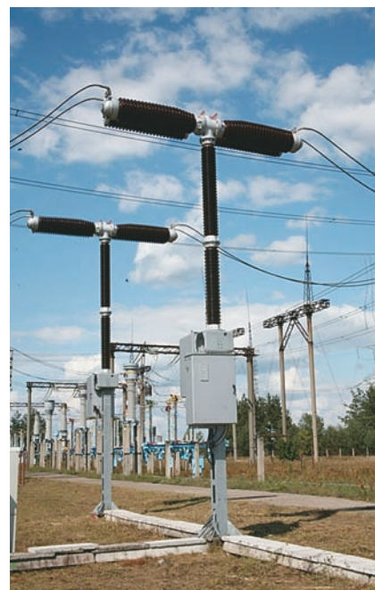
Элегазовые выключатели 330 кВ
