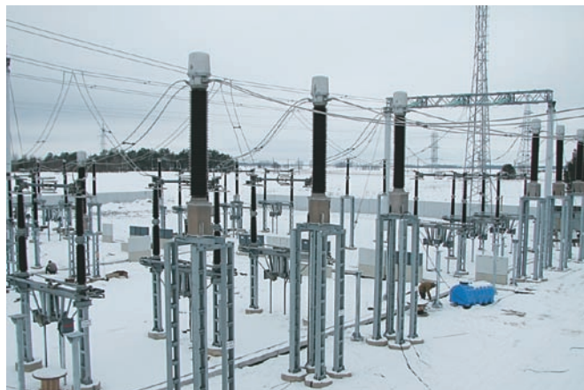
Ведутся электромонтажные работы на ОРУ 330 кВ ПС «Барановичи»
