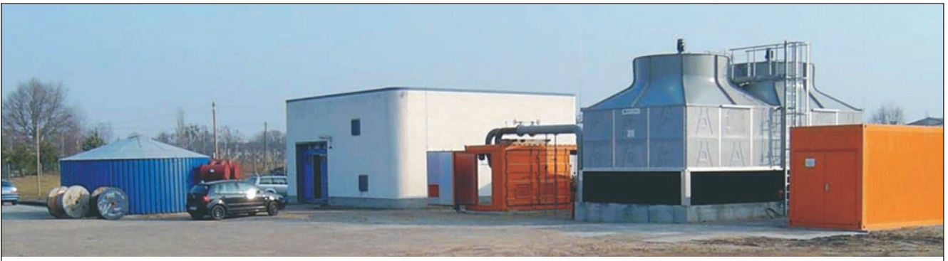
Рис. 2. Общий вид геотермальной станции Нойштадт-Глеве, Германия
