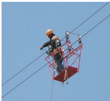
Работы на ВЛ 750 кВ, Мстиславльский район
