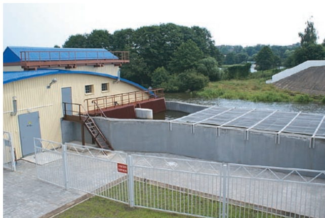
Мини-ГЭС на водосбросе Минской ТЭЦ-3
