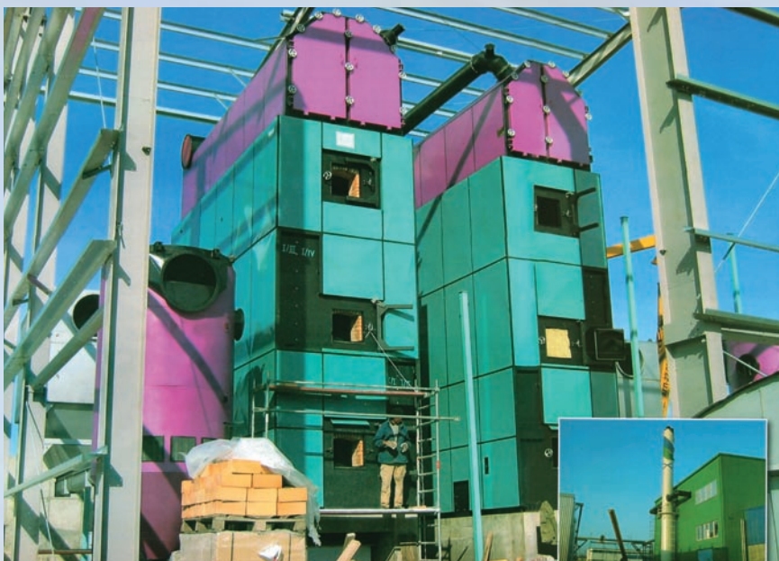
Сооружение котельной 3 x 6000 кВт с водогрейным котлом (120 °С) с гидравлической колосниковой решеткой «ЛЕСОБАЛТ» (Калининград, Россия)
