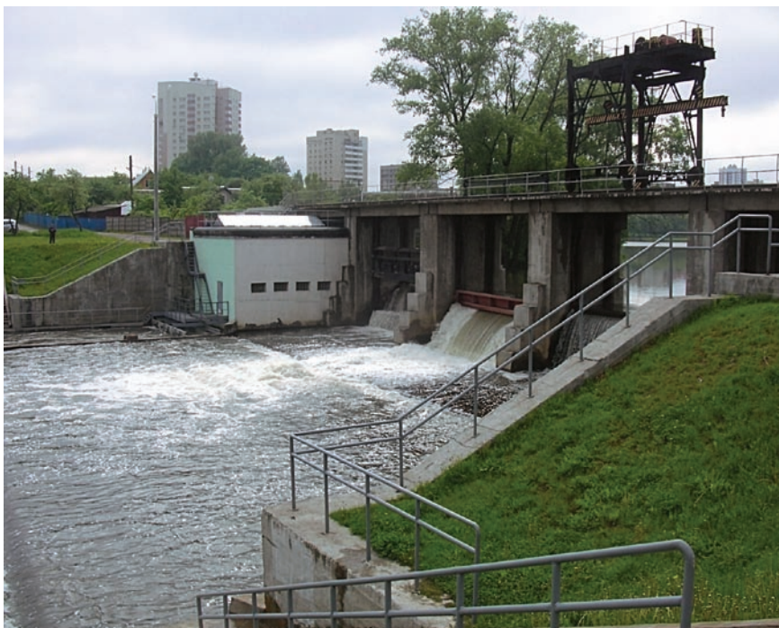
ГЭС на водосбросе Минской ТЭЦ-2
