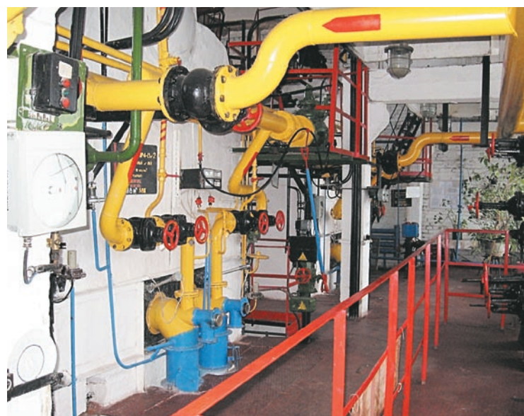
Котельная завода торфяного машиностроения «Большевик»
