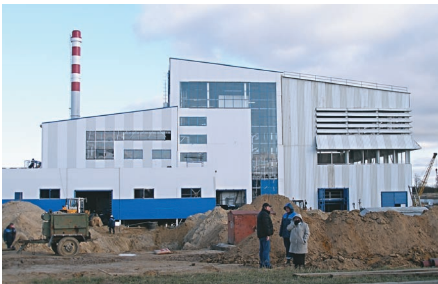
Строительство Пружанской мини-ТЭЦ на завершающем этапе
