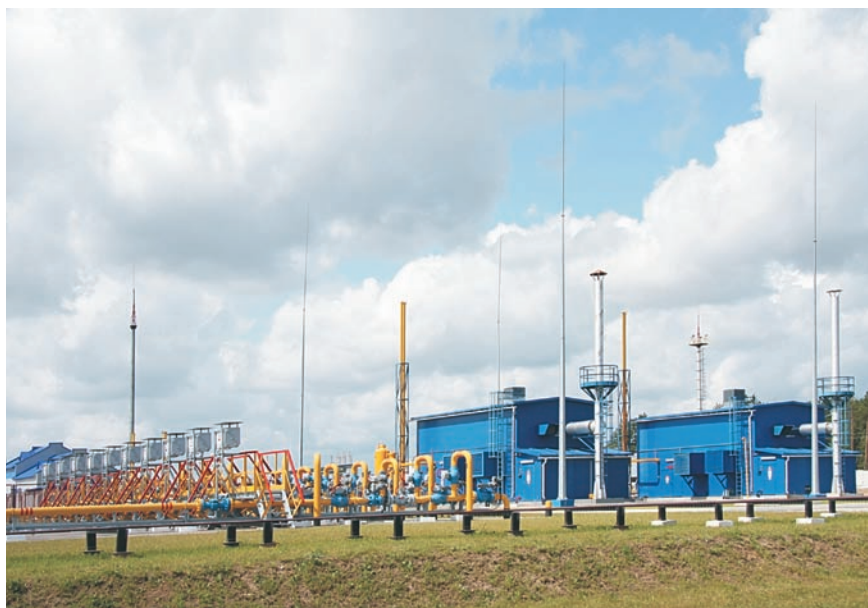
Промплощадка Мозырского ПХГ
