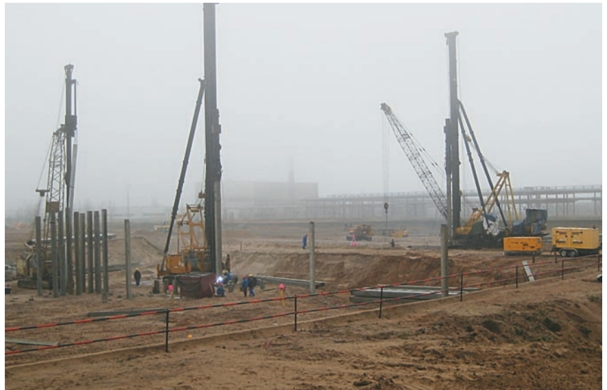
Начало работ по строительству главного корпуса ПГУ 399 Минской ТЭЦ-5
