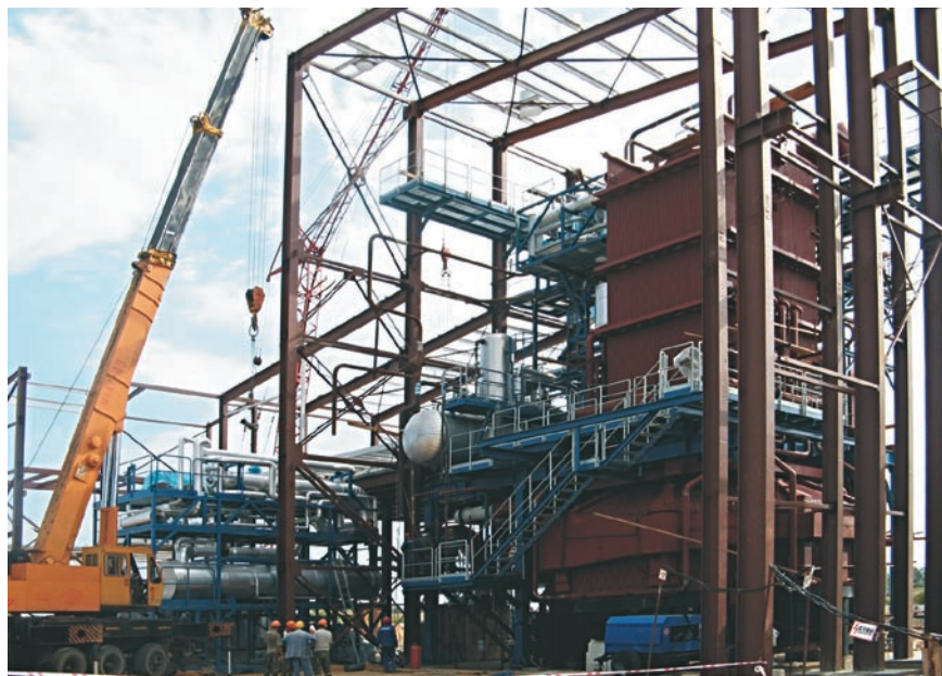
Монтаж главного корпуса Пружанской мини-ТЭЦ
