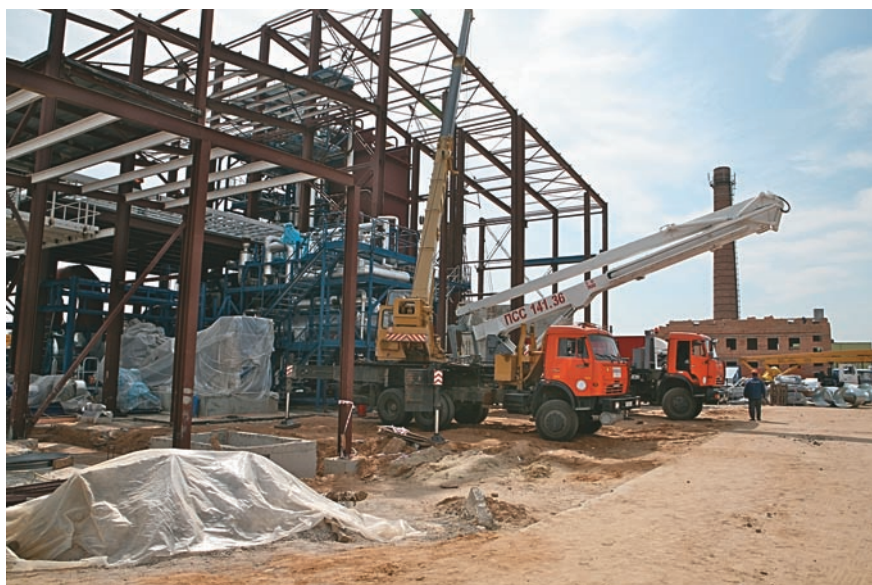
Строится главный корпус Пружанской мини-ТЭЦ. Ноябрь 2009 года
