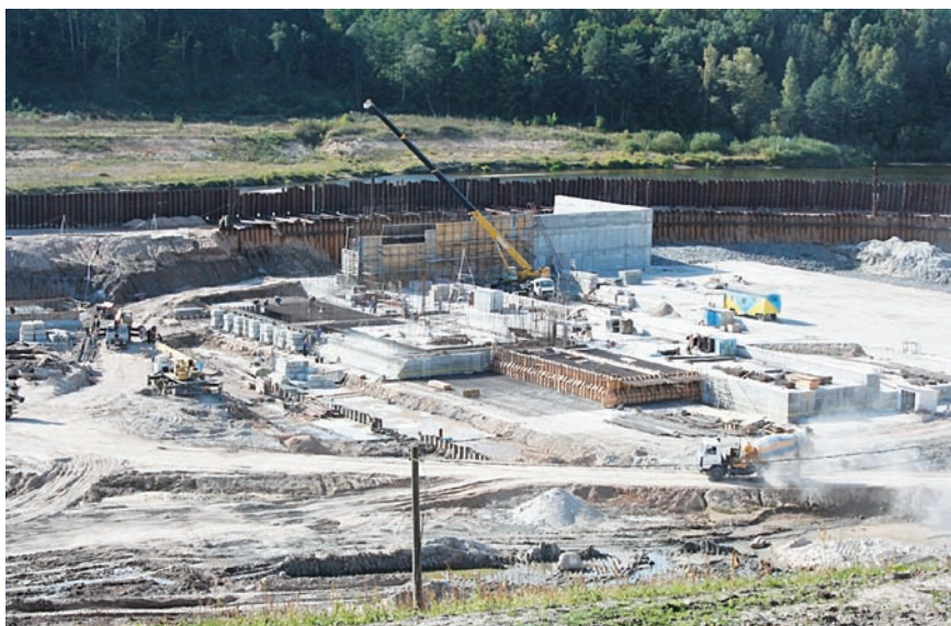
Работы по возведению береговых устоев и водосливной плотины Гродненской ГЭС
