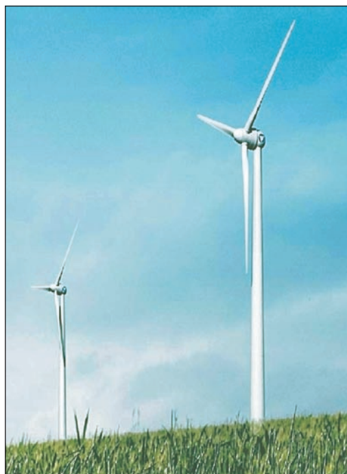
Ветроэнергетическая электростанция Vensys –CKD70 чешского производства мощностью 1500 кВт
