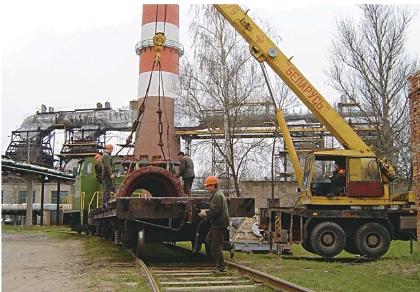
Разгрузка нового оборудования
