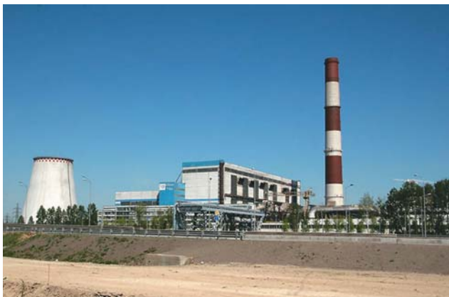
Южная ТЭЦ (г. Санкт-Петербург)
