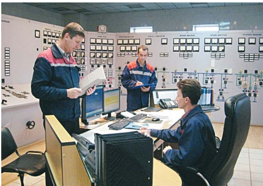
На ГЩУ ведущий инженер по охране труда А. В. Соломонов, старший дежурный электромонтер А. П. Ялыхов, начальник смены станции В. В. Соколовский
