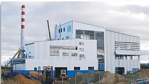
Строительство Пружанской ТЭЦ на древесном топливе и торфе (MW Biorpower)
