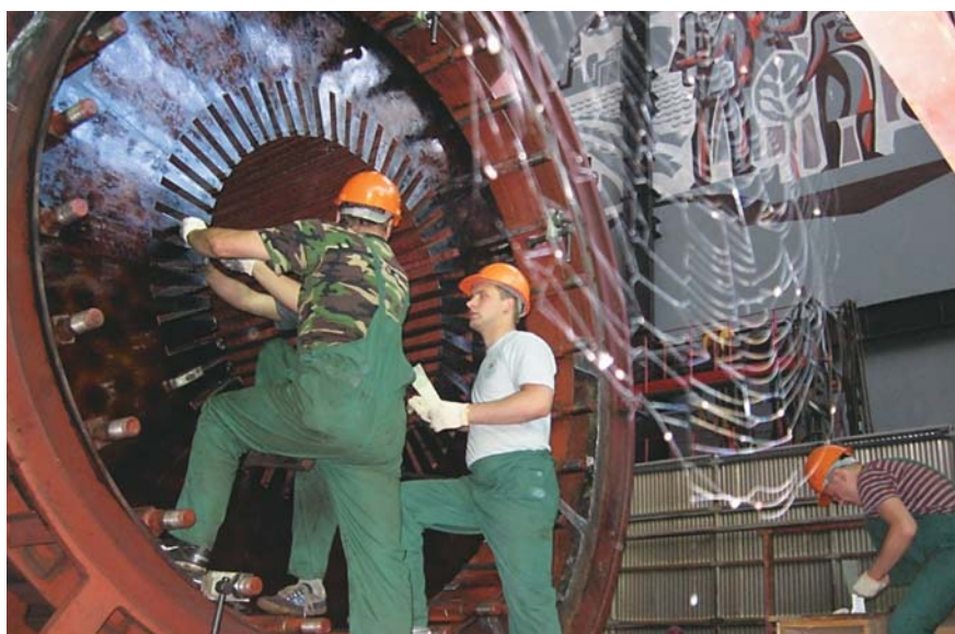
Восстановительный ремонт резервного статора генератора. Замену концевых пакетов ведет бригада завода «Силловые машины» (Санкт-Петербург)
