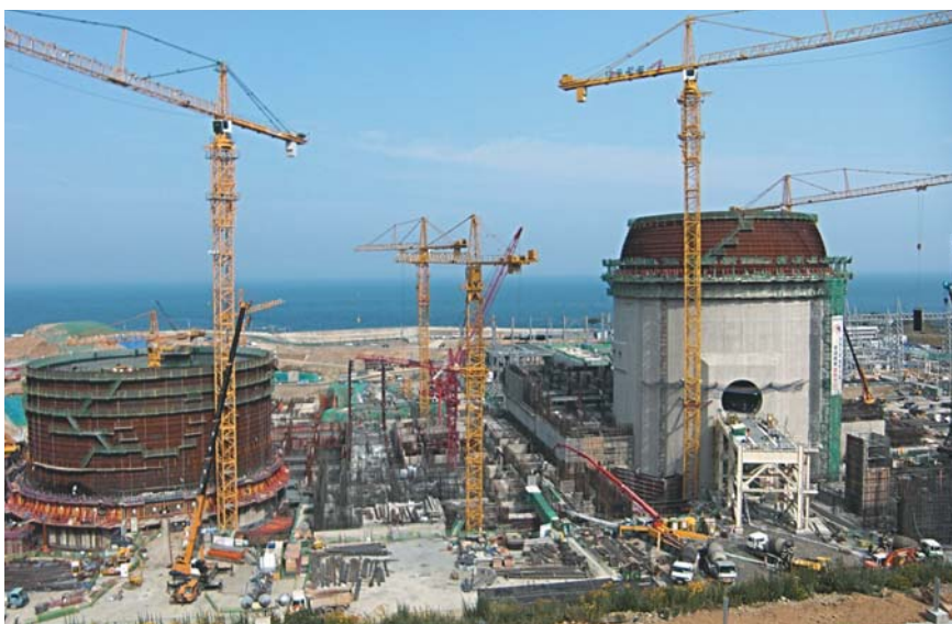
Строящиеся блоки АЭС в Южной Корее
