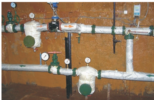
После ремонта тепловой изоляции в индивидуальном тепловом пункте
