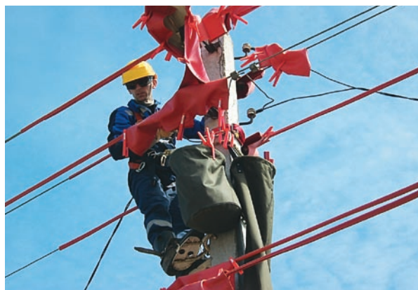
Замена ввода в жилой дом без отключения ВЛ
