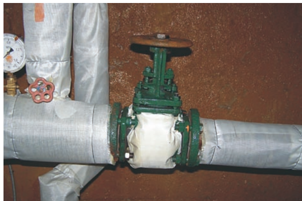
Произведена замена запорной арматуры
