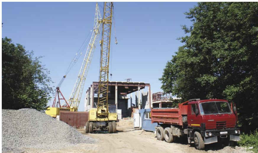
Строительство береговой насосной станции
