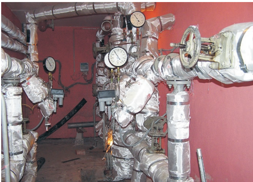
Тепловой узел детского сада №8 г. Гомеля готов к приему теплоносителя
