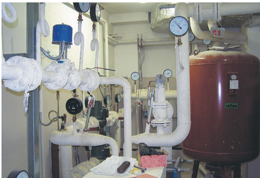
Гидравлические испытания системы теплоснабжения
