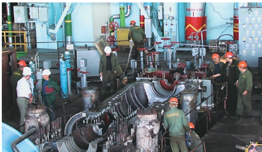
Реконструкция паровой турбины на Гродненской ТЭЦ-2
