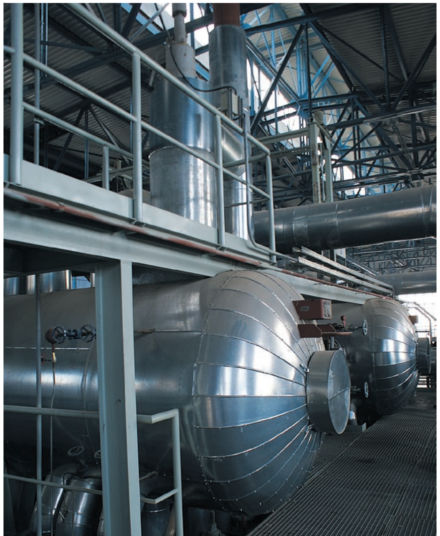
Котел-утилизатор фирмы «SES ENERGY» (Словакия), модель SES-212,5/57,2-7 9810,7-490/208
