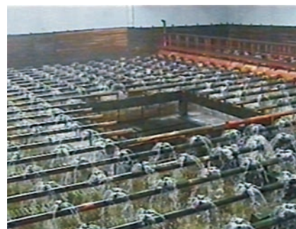
Рис. 1. Внешний вид модернизированной градирни № 1 Гродненской ТЭЦ-2, имеющей в основании квадратную форму, с встроенным аэродинамическим завихрителем по периметру воздухоподводящих окон и вентиляционным окном в центре оросителя
