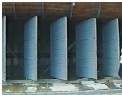
Рис. 1. Внешний вид модернизированной градирни № 1 Гродненской ТЭЦ-2, имеющей в основании квадратную форму, с встроенным аэродинамическим завихрителем по периметру воздухоподводящих окон и вентиляционным окном в центре оросителя
