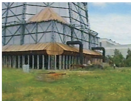
Рис. 1. Внешний вид модернизированной градирни № 1 Гродненской ТЭЦ-2, имеющей в основании квадратную форму, с встроенным аэродинамическим завихрителем по периметру воздухоподводящих окон и вентиляционным окном в центре оросителя
