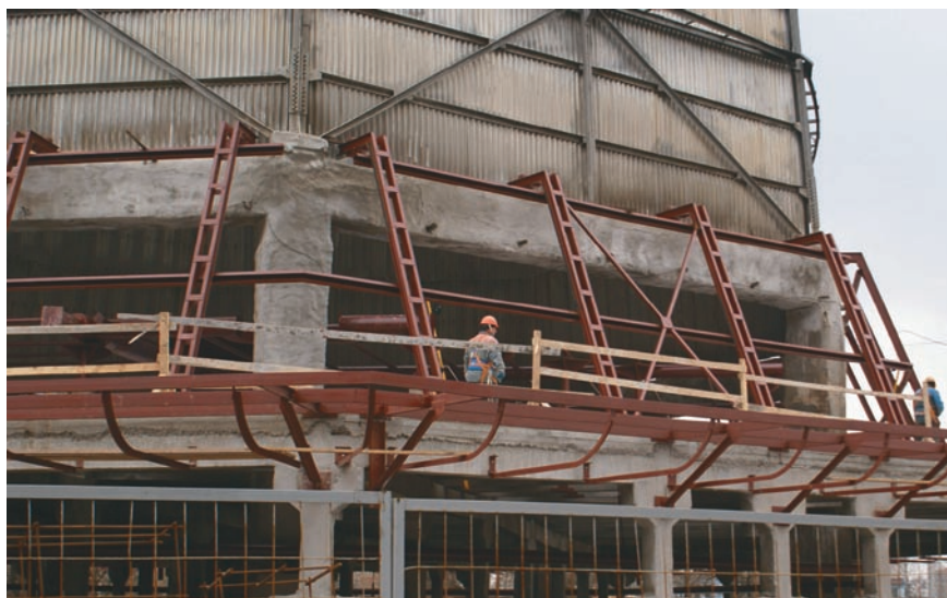
Реконструкция градирни блока ПГУ-230
