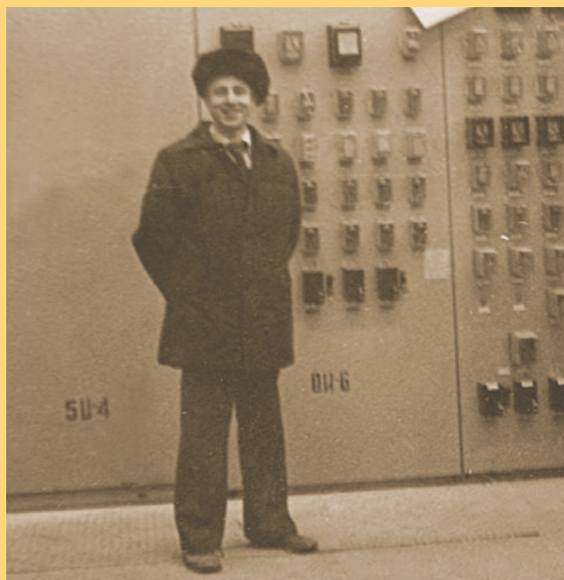
Л.С. Прибыльский у главного щита управления ТЭЦ-3 (70-е годы)
