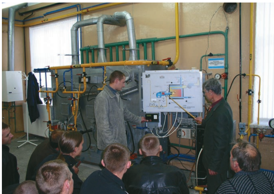
Изучение автоматики котлов
