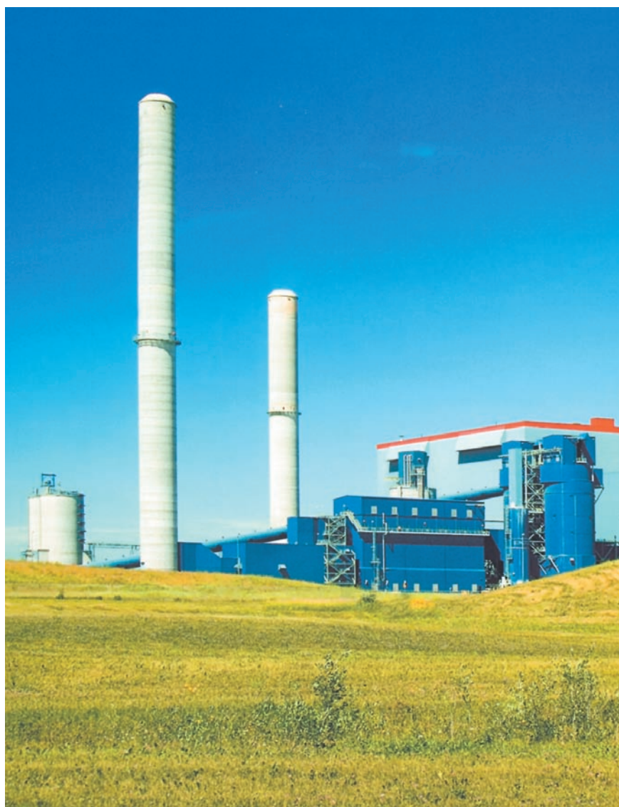
Установка, работающая на угле при сверхкритической температуре и давлении мощностью 450 МВт, Канада
