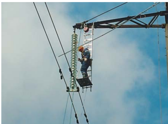
Соединение проводов марки АС-300 методом опрессовывания
