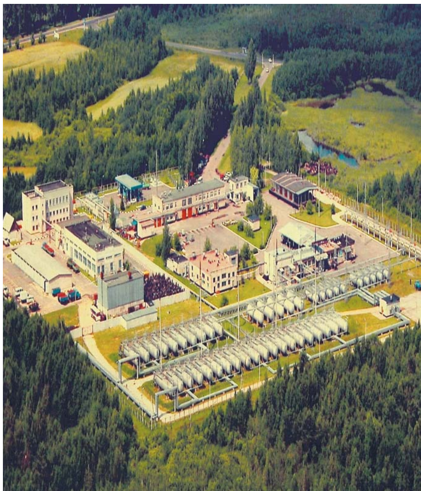
Полоцкая газонаполнительная станция
