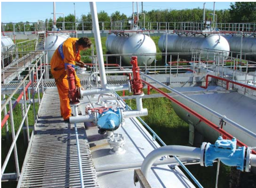
Газонаполнительная станция. Проверка утечки газа
