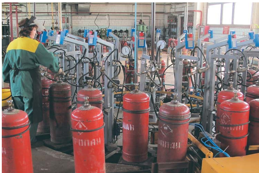
Электронная установка наполнения баллонов 2007 года выпуска
