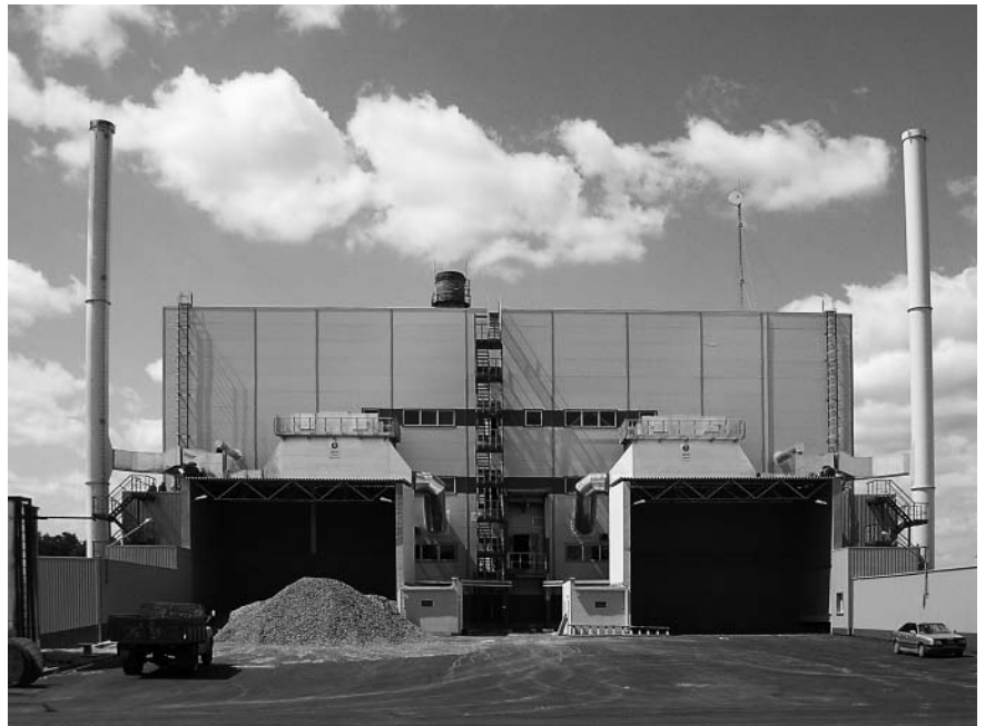
Бункеры загрузки топлива Речицкой мини-ТЭЦ
