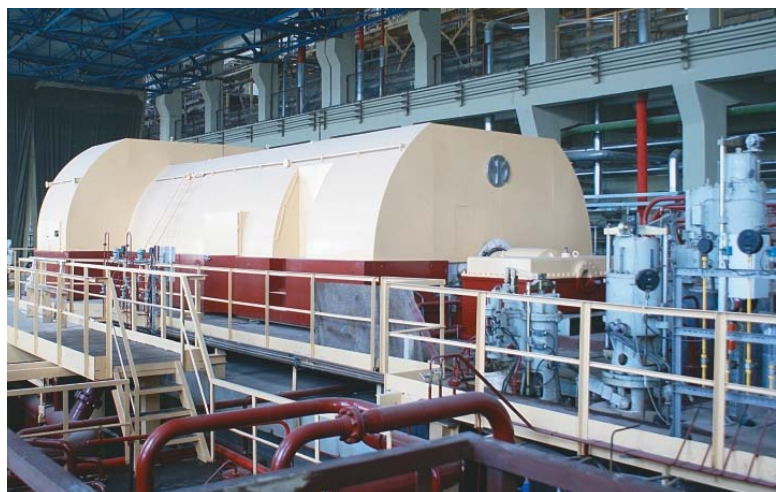
Паровая турбина блока ПГУ-230
