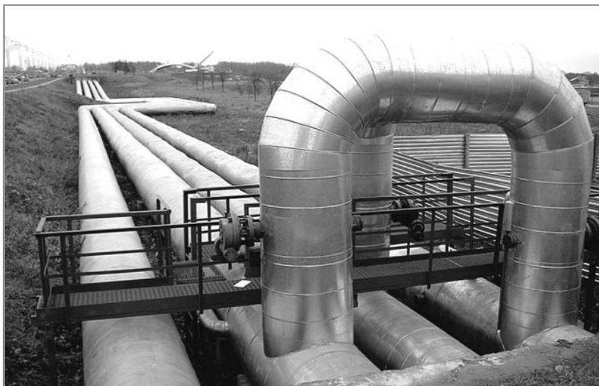
Тепломагистраль №1 после реконструкции, г. Гродно
