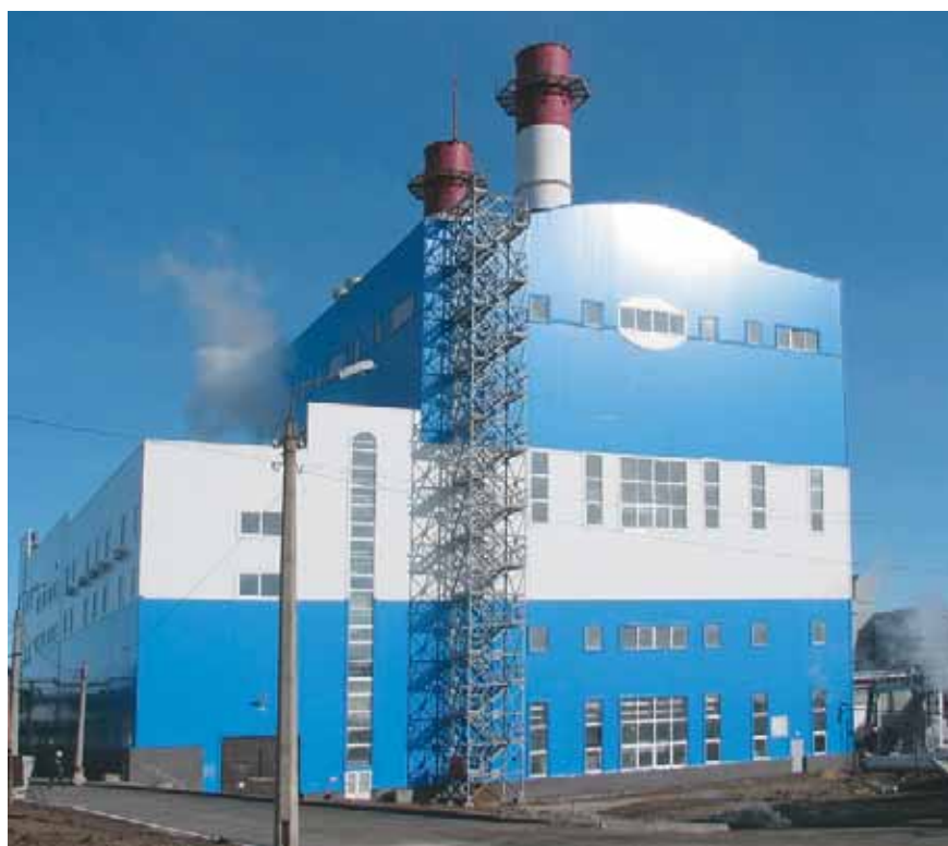
Блок ПГУ-115 на Северо-Западной котельной в г. Курске
