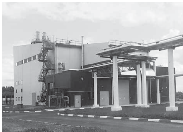
Здание мини-ТЭЦ с двумя ГПА РУП «Завод газетной бумаги», г. Шклов
