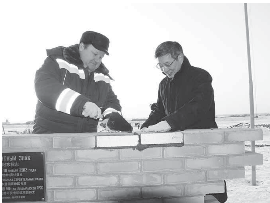
Торжественная закладка первого камня в фундамент ПГУ Лукомльской ГРЭС
