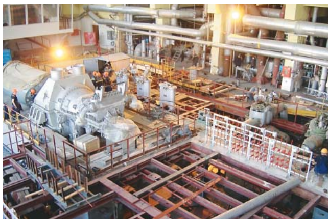
Общий вид монтажной площадки т/а № 2
