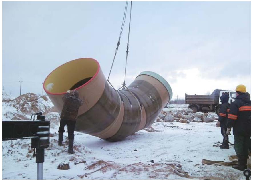
Монтаж отвода DN 2000 на Минской ТЭЦ-5
