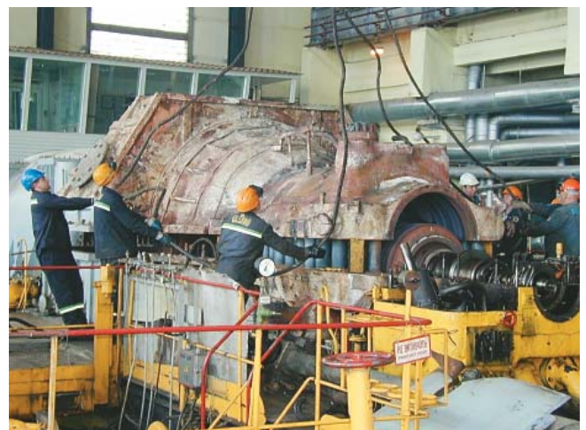
Демонтаж турбины ст. № 2 Витебской ТЭЦ
