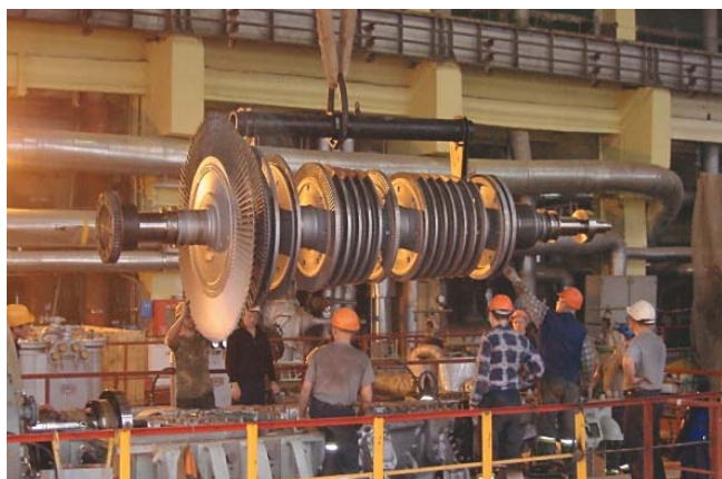
Установка ротора турбоустановки ПТ-40/50-8,8/1,0
