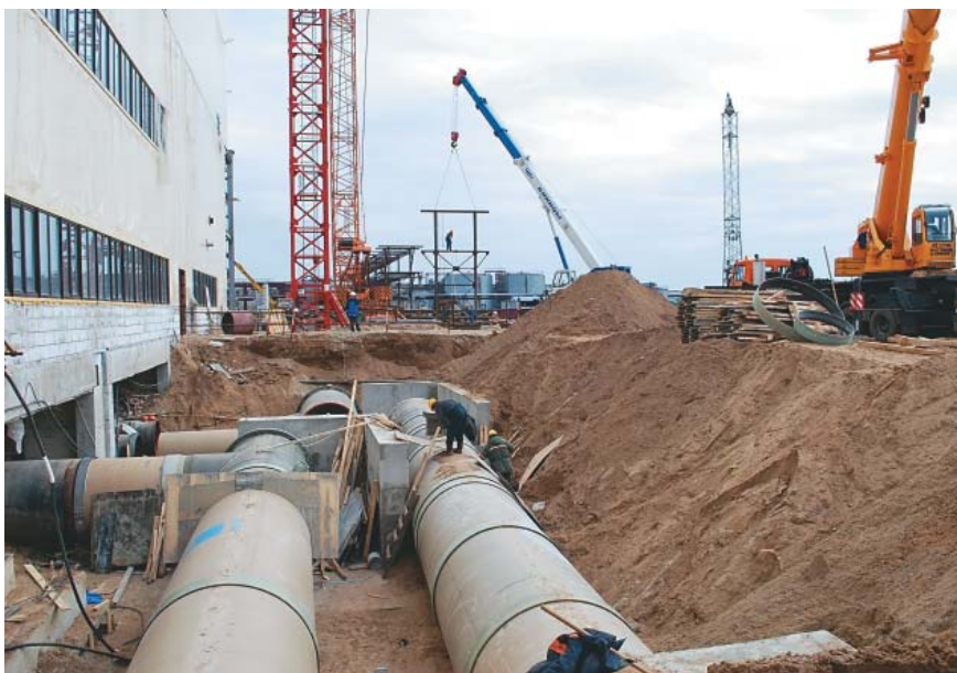
Монтаж стеклопластиковых циркуляционных водоводов DN 2000 на Минской ТЭЦ-5
