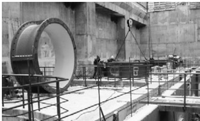
Идет монтаж основного гидроэнергетического оборудования на Гродненской ГЭС
