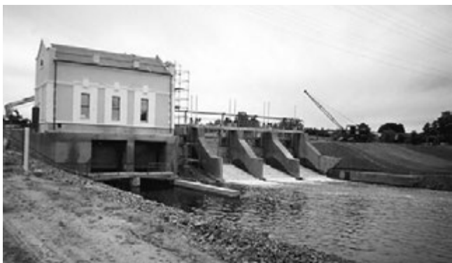
Новоселковская ГЭС после восстановления
