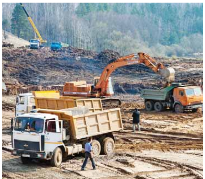
Начало разработки котлована Гродненской ГЭС
