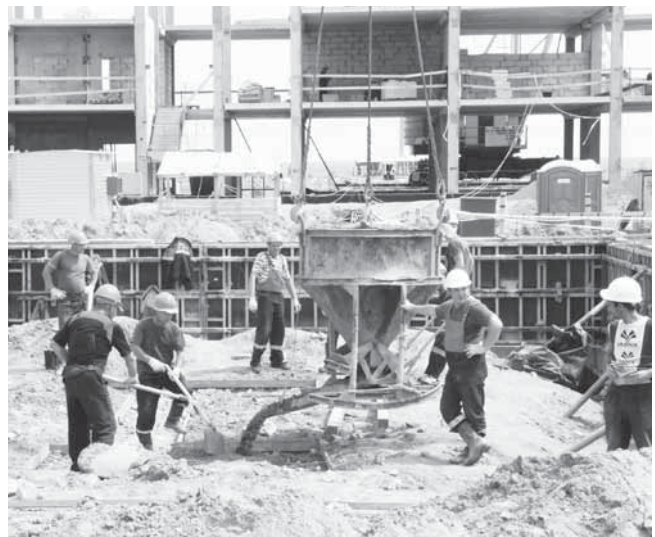
На строительной площадке Белорусской АЭС
