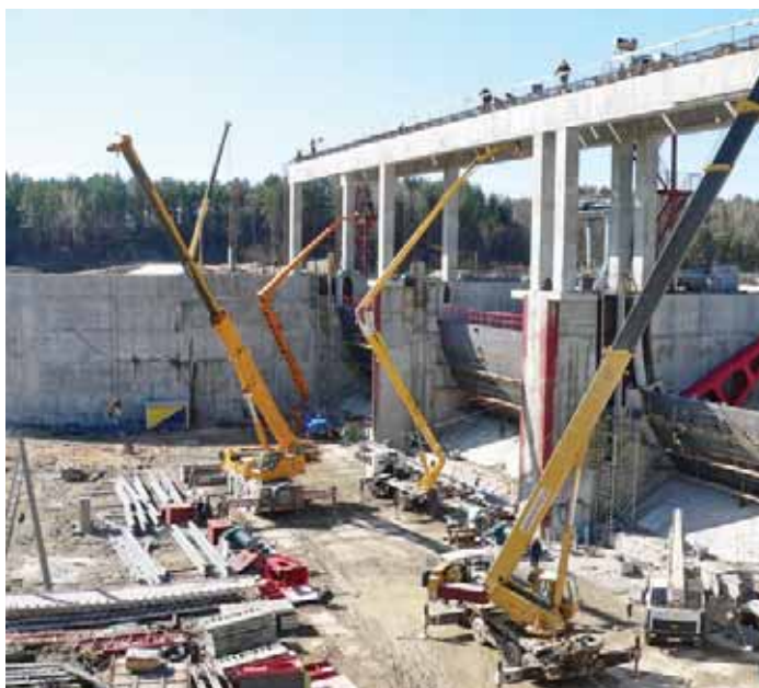
Монтаж затворов водосливной плотины
