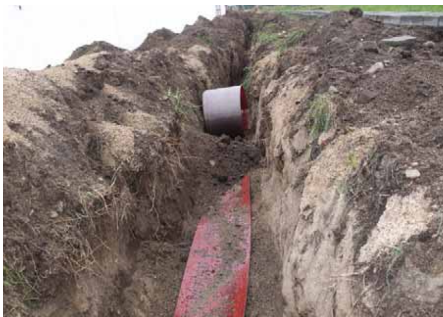
Укладка ленты защитно-сигнальной
