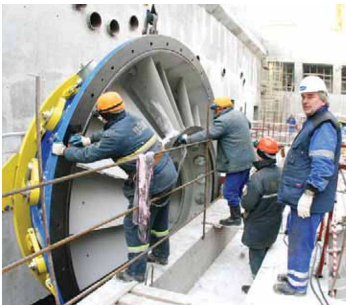
Монтаж направляющего аппарата гидротурбины
