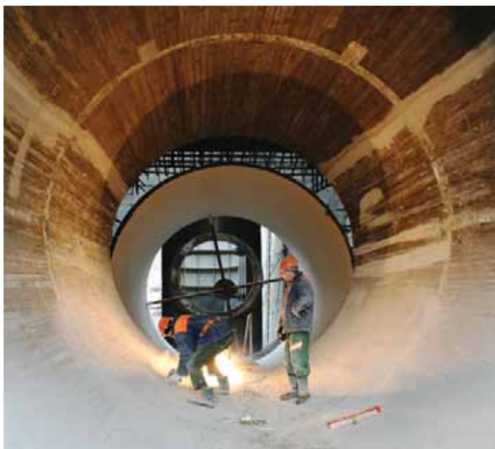
Шлифовка поверхности отводящего канала гидроагрегата
