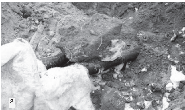
1. Дефекты при разгрузке 2. Нарушение при обратной засыпке
