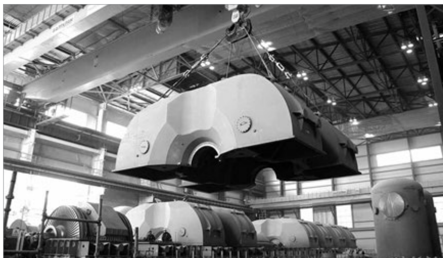
Монтаж турбины энергоблока № 1 на Нововоронежской АЭС-2
