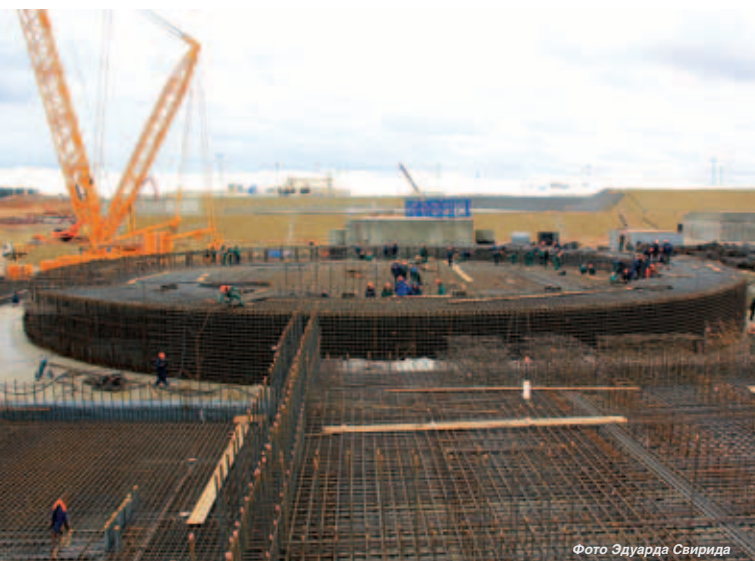
На строительной площадке БелАЭС
