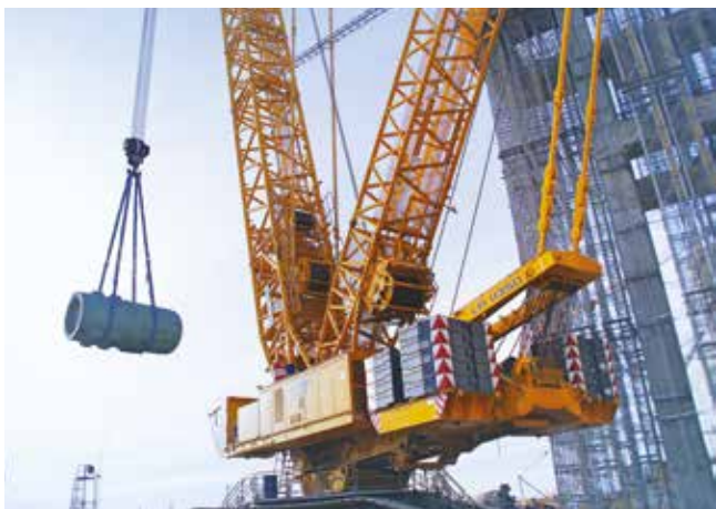
Первый этап установки корпуса реактора второго энергоблока БелАЭС
