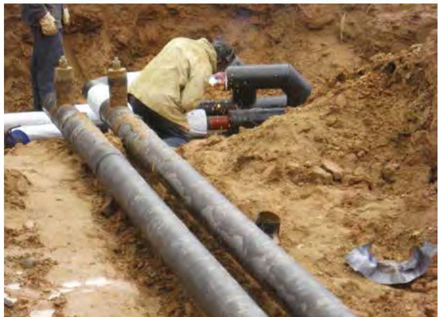
Монтаж тепловых сетей
