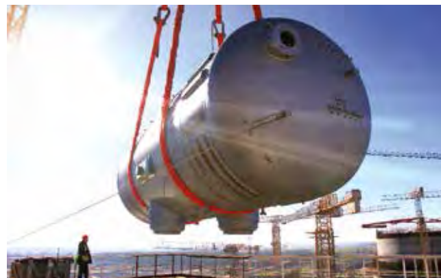
Перемещение парогенератора в здание реактора 1-го блока БелАЭС
