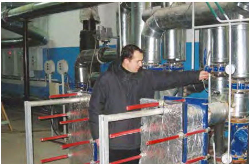
Проверка теплового пункта потребителя
