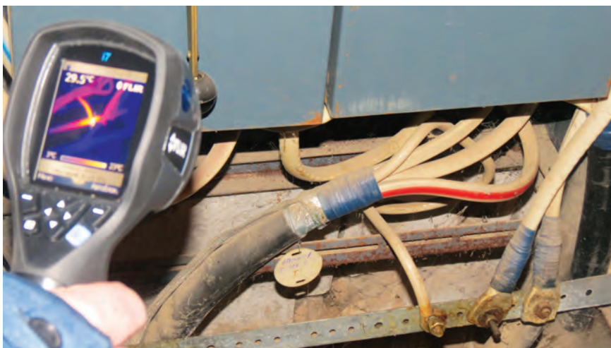
Рис. 2. Определение ослабления контактного соединения с помощью тепловизора
