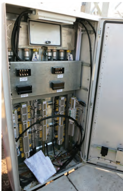
Шкаф присоединения ПС 110 кВ «Приречная» с устройствами сопряжения типа Brick производства компании General Electric
