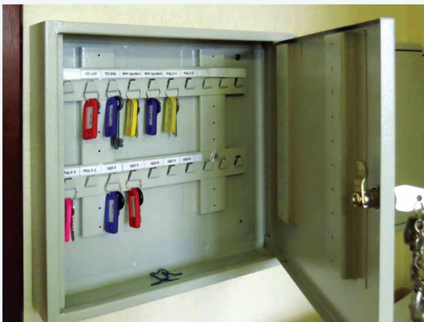
Рис. 1. Запираемый ящик для хранения ключей от электроустановок
