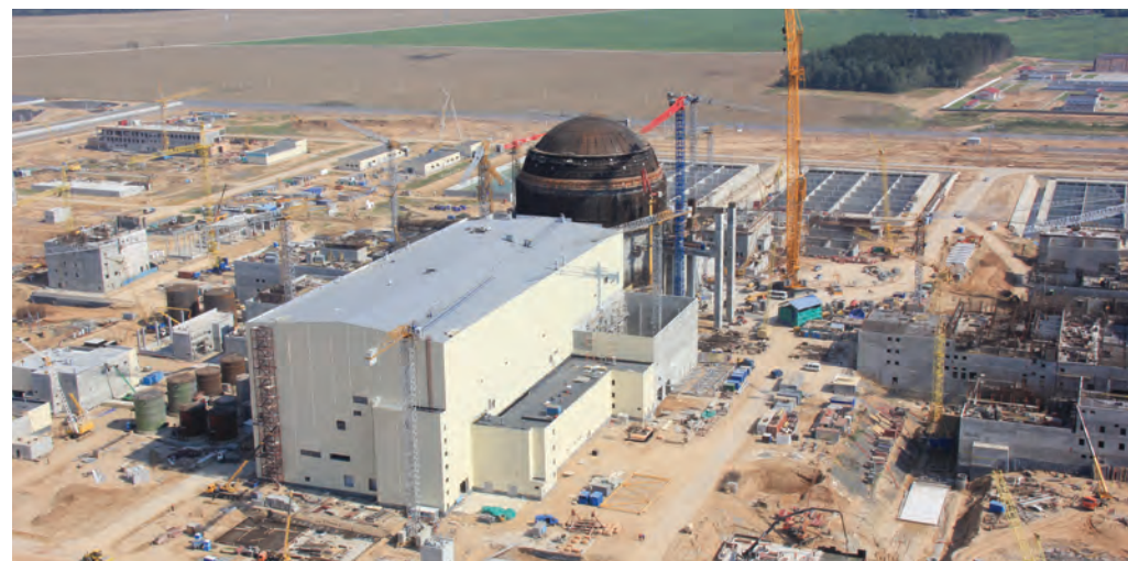
Стройплощадка Белорусской АЭС, здание реактора энергоблока № 1
