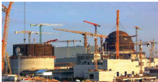
Стройплощадка Белорусской АЭС. Фото Э.И. Свирида
