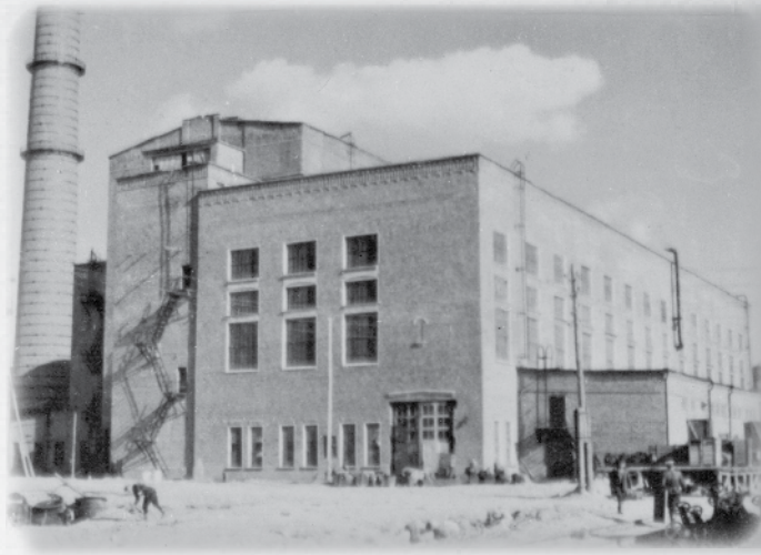
Здание машинного зала Минской ТЭЦ-3, 1961 год
