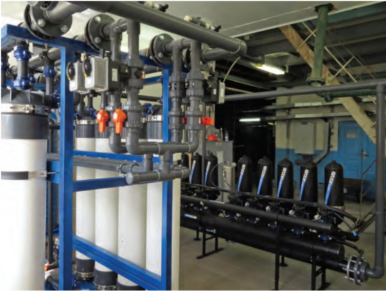
Рис. 5. Опытная водоочистная установка для удаления органических веществ из природных вод
