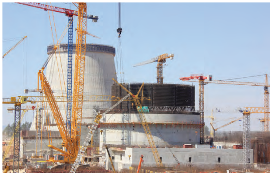
На строительной площадке АЭС, август 2015 года
