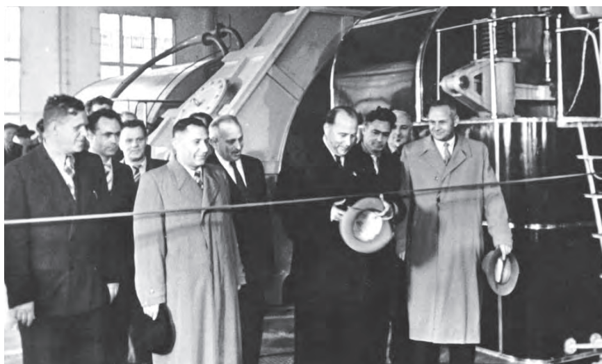
Сдача в эксплуатацию 1-й очереди Василевичской ГРЭС, 1958 год
