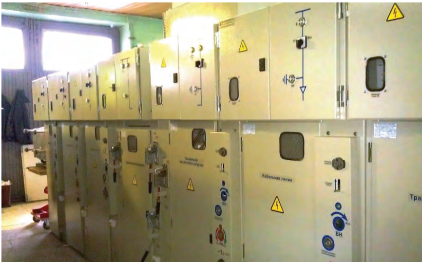
Рис. 2. Восьмикамерный блок КСО-1-БЭМН
