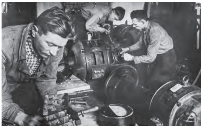
Молодежная бригада на восстановлении Гомельской электростанции, 1944 год
