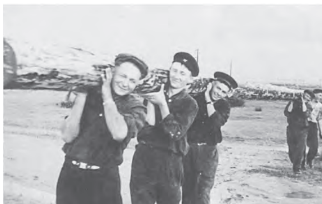
Бригада электромонтеров на установке опор 0,4 кВ, 1945 год
