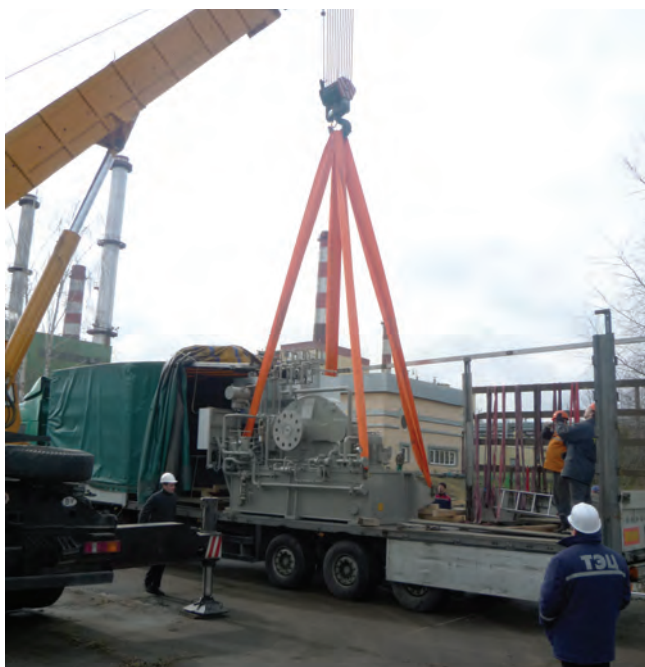
Подготовка к разгрузке турбины Siemens SST -110/060 TANDEM для Оршанской ТЭЦ, март 2014 года
