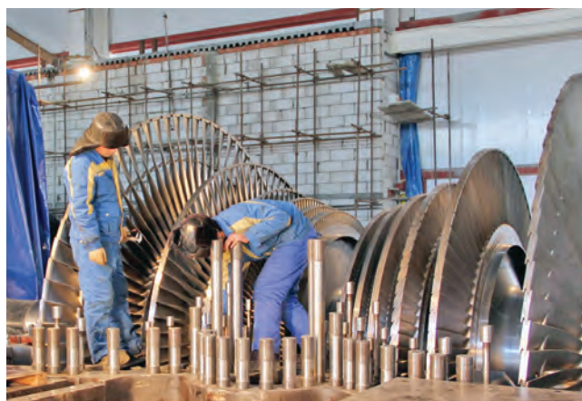
Монтаж ЦНД паровой турбины Минской ТЭЦ-5
