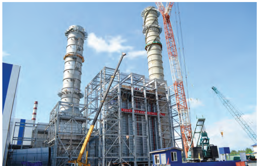
Строительство ПГУ 427 МВт на Брезовской ГРЭС
