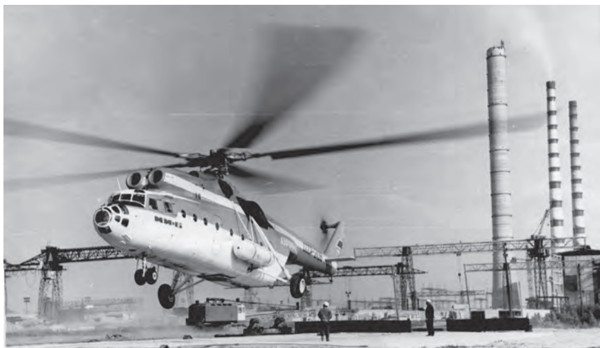
Монтаж дымовой трубы 2-й очереди Лукомльской ГРЭС, 1969 год
