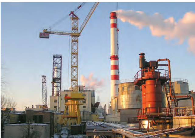
Лидская ТЭЦ в ходе реконструкции
