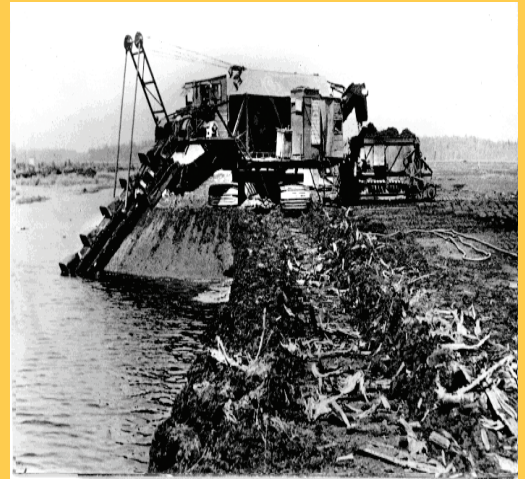
Добыча торфа экскаваторным способом
