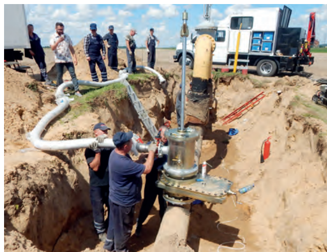
Установка системы перекрытия потока газа в трубопроводе под давлением Ду 300 мм
