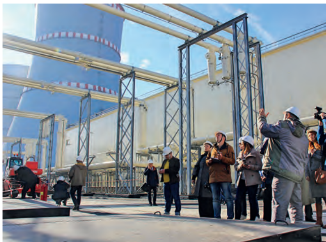
Зарубежные журналисты на площадке строительства Белорусской АЭС
