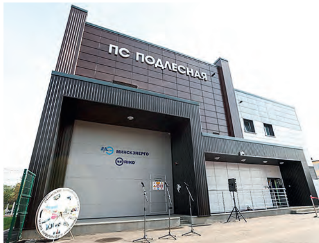
Обновленная ПС 110/10 кВ «Подлесная»
