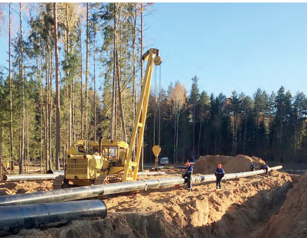
Укладка газопровода в траншею
