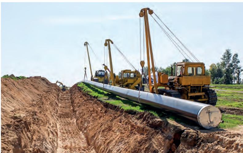
Работы по укладке газопровода высокого давления
