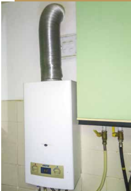
Рис. 5. Дымоотвод, выполненный из тонкостенной алюминиевой гофрированной трубы
