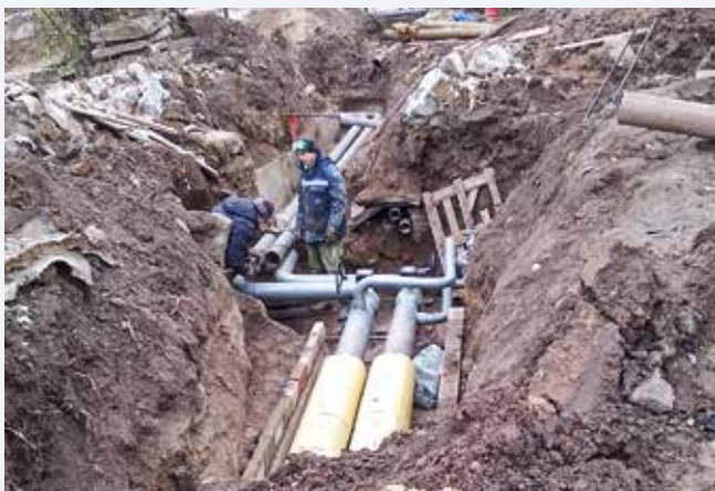
Работы, проводимые с нарушениями: отсутствует ограждение, не обеспечена сохранность коммуникаций и безопасность людей
