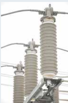
Оптический трансформатор тока 110 кВ FOCS-FS
