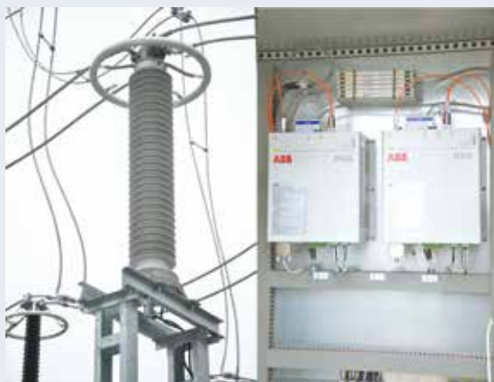
Оптический трансформатор тока 330 кВ FOCS-FS
